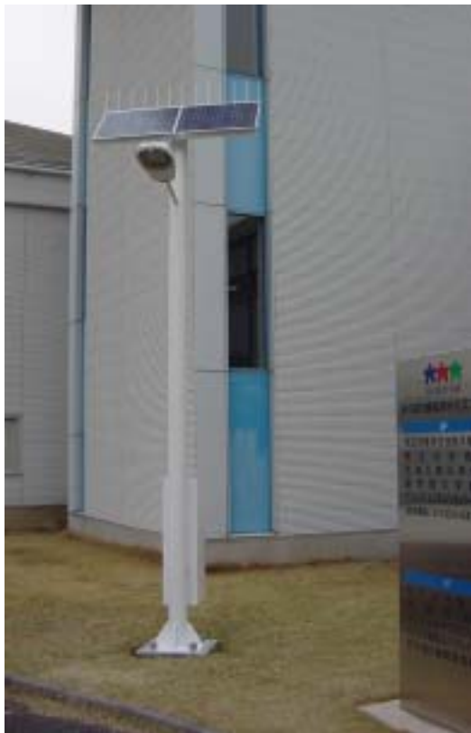
埼玉県埼玉新都心 産学交流プラザ玄関入口照明 (EPL-180)
