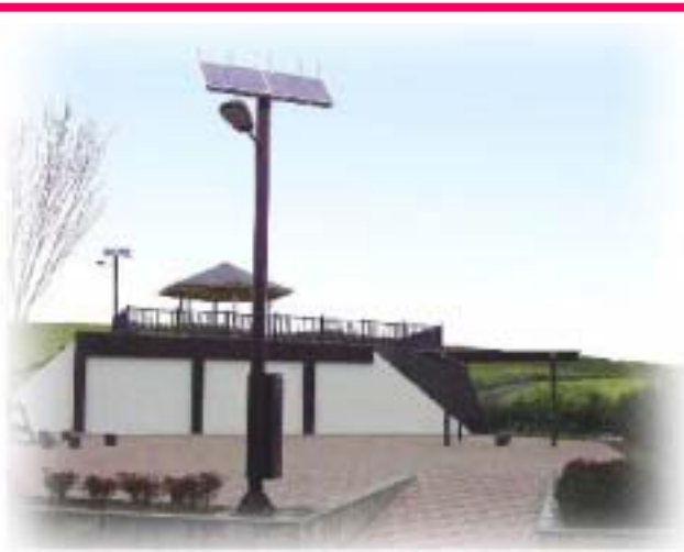
山梨県 花火公園 公園照明 (EPL-180 2基)
